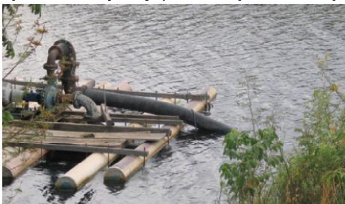
Figura 14: Estrutura para captação de fio de água em curso de água superficial.
