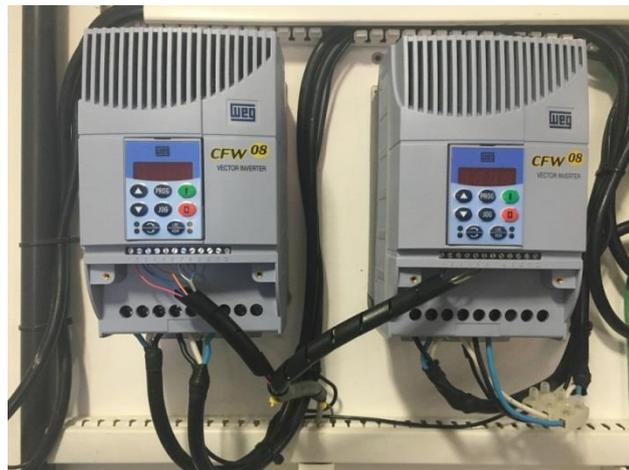
**Figura 5.4** Inversores de frequência utilizados para acionar os sistemas de impulsão.
