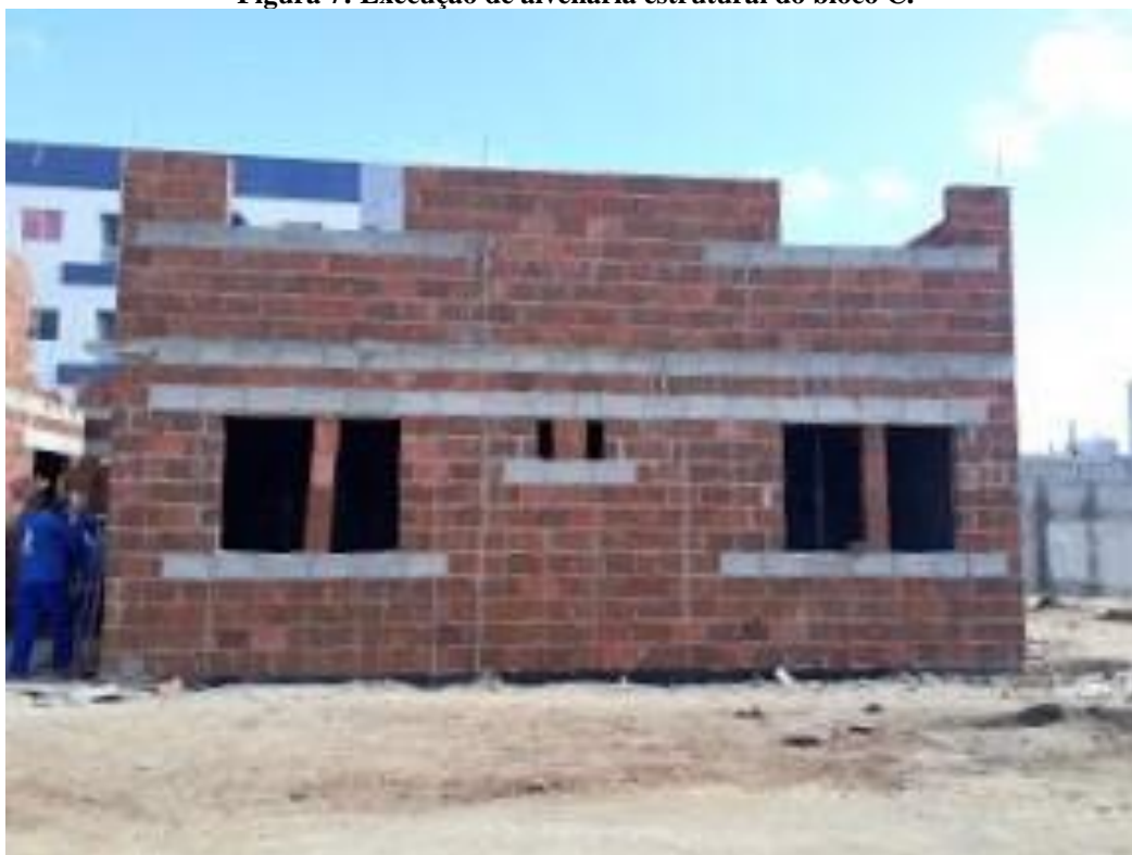
Figura 7: Execução de alvenaria estrutural do bloco C.
